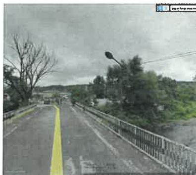
Pod spre CROSI din Str. Căminelor
